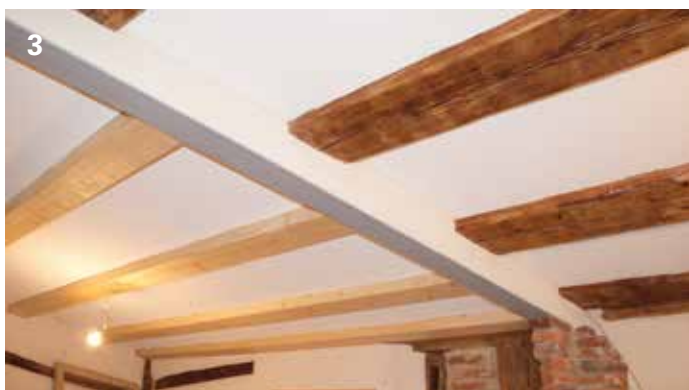
Fertige Decke mit originalgetreuer Untersicht
