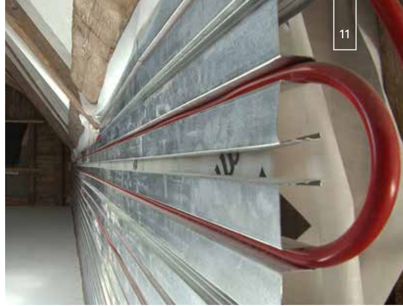
Wandflächen können mit demselben System zum Heizen und Kühlen genutzt werden.
