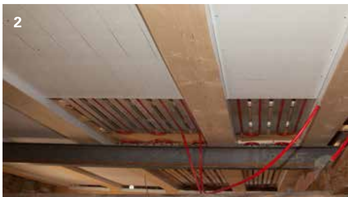
Klima-Top-Profile zwischen den Balken verlegt und beplankt
