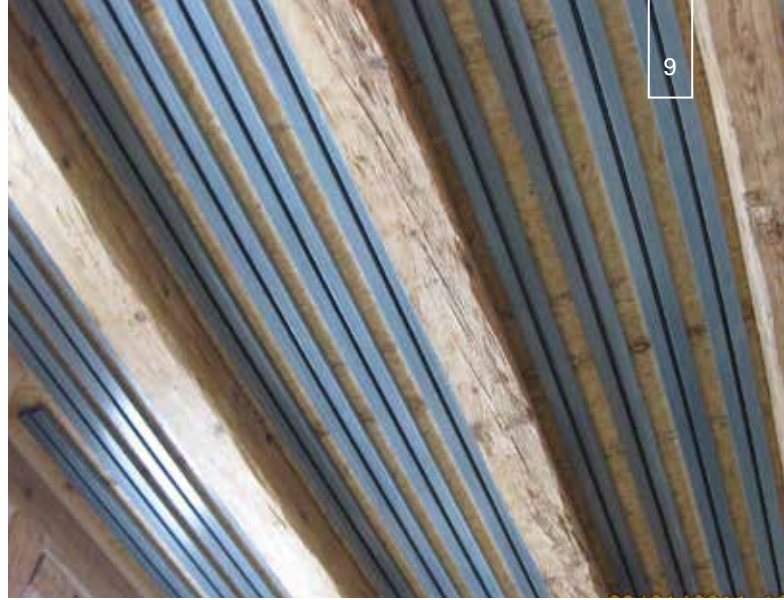
Direktmontage der Klima-Top-Profile an einer Balkendecke
