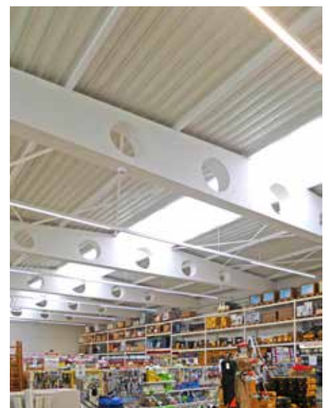
„TopHaus“ Baumarkt, Brixen: Die Klimadecke temperiert den bis zu 7,5 Meter hohen Raum gleichmäßig und effizient. Selbst im Rekordsommer 2015 genossen die Kunden und Mitarbeiter angenehm kühle Räume – bei Außentemperaturen über 35\text{ }^{\circ}\text{C} .
