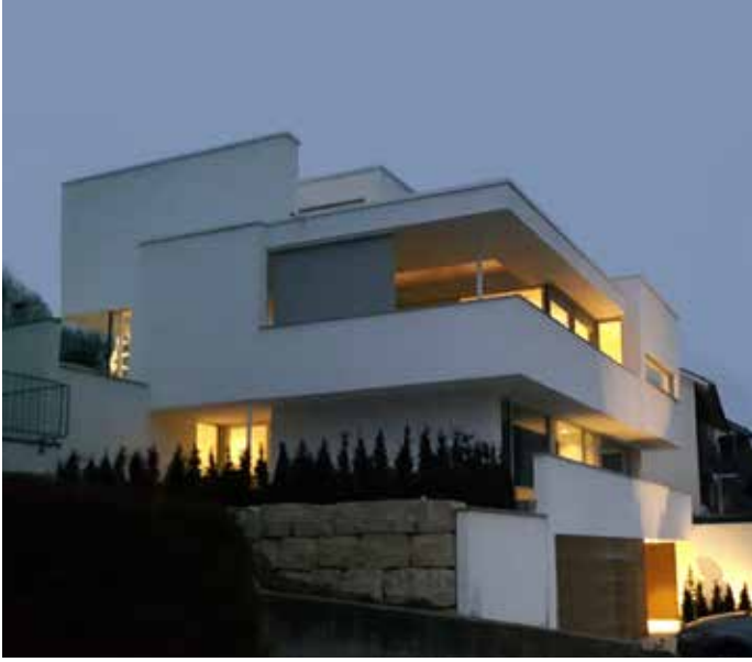
Neubau Wohnhaus am Hang | www.diemer-architekten.de
