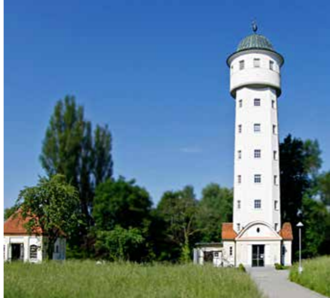
Sanierung Wasserturm Konstanz (erbaut 1910): 100 Jahre nach seiner Erbauung wurde der Wasserturm mit Klimatop und Wärmepumpen saniert. Jetzt herrscht innerhalb der historischen Beton-Klinkerstein-Konstruktion ein ideales Raumklima für Büros und Seminarräume.
