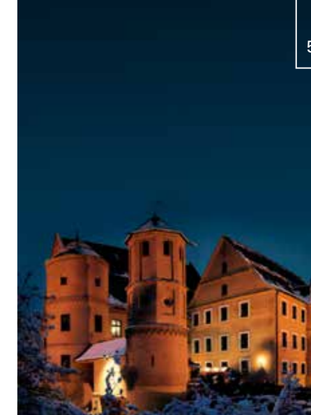
Sanierung Schloss Wertingen (14. Jh.): Die Klimadecke temperiert das Schloss äußerst energieeffizient, obwohl kein Vollwärmeschutz vorhanden ist. Selbst bei frostigen -16\text{ °C} Außentemperatur genügen 39\text{ °C} Vorlauftemperaturen für ein behagliches Raumklima bei 22\text{ °C} .
