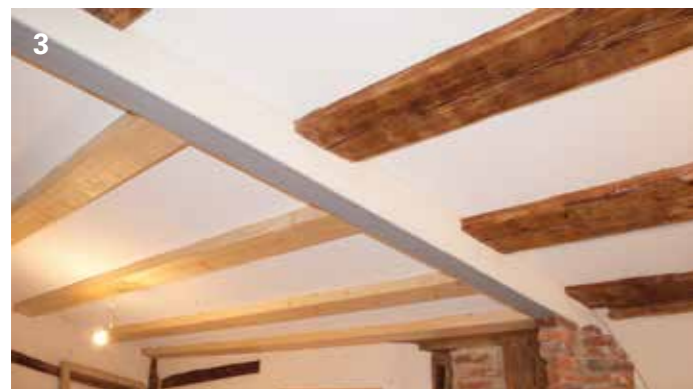
fertige Decke mit originalgetreuer Untersicht
