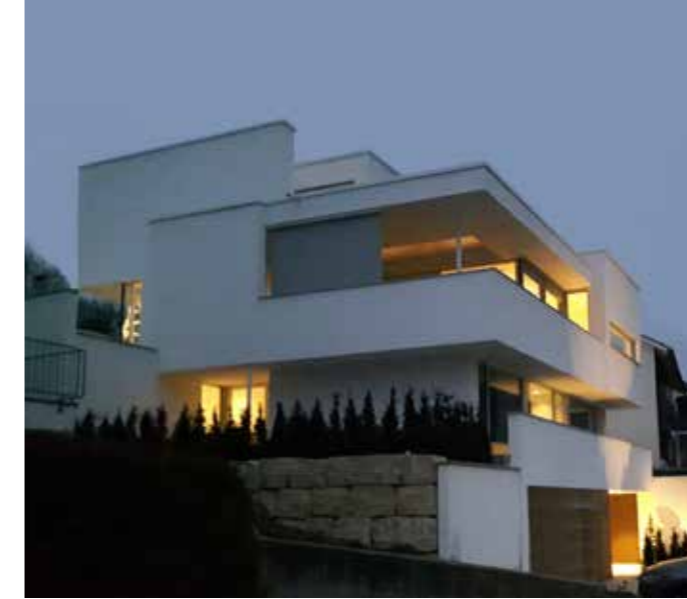
Neubau Wohnhaus am Hang | www.diemer-architekten.de
