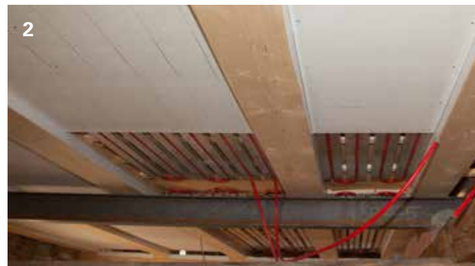
Klimatop-Profile zwischen den Balken verlegt und beplankt
