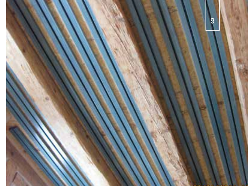
Direktmontage der Klimatop-Profile an einer Balkendecke
