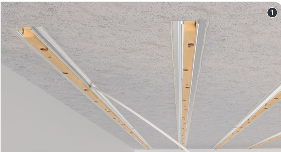
Einrollen des Raum-K Systemrohrs in das Klimasan Duo 188
