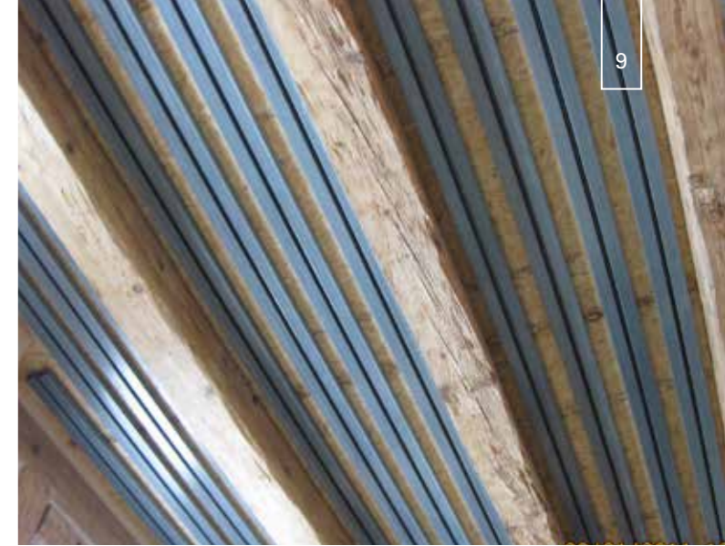
Direktmontage der Klimatop-Profile an einer Balkendecke
