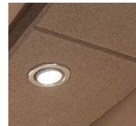
Einbausports sind auch in den Reapor-Körpern möglich
