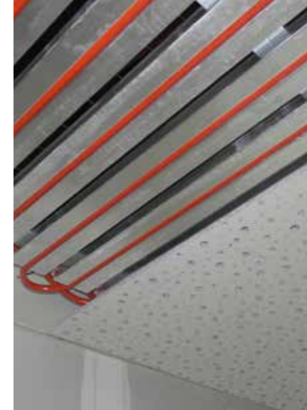
Abgehängte Klimadecke
