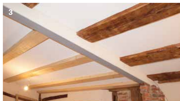
fertige Decke mit originalgetreuer Untersicht
