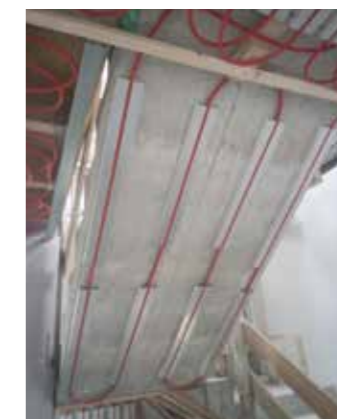
Das Klimatop-Profil findet überall Platz: hier an der Treppenunterseite.
