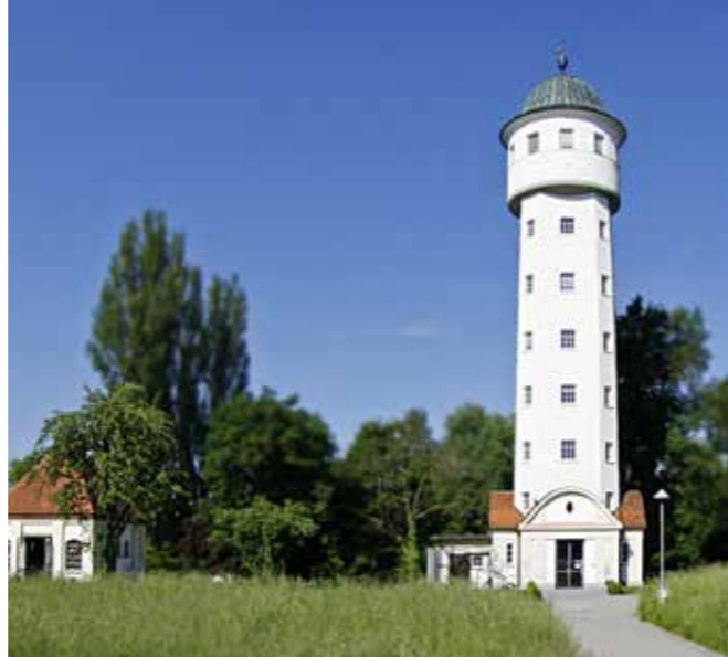
Sanierung Wasserturm Konstanz (erbaut 1910): 100 Jahre nach seiner Erbauung wurde der Wasserturm mit Klimatop und Wärmepumpen saniert. Jetzt herrscht innerhalb der historischen Beton-Klinkerstein-Konstruktion ein ideales Raumklima für Büros und Seminarräume.
