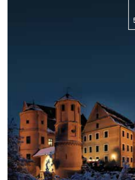
Sanierung Schloss Wertingen (14. Jh.): Die Klimadecke temperiert das Schloss äußerst energieeffizient, obwohl kein Vollwärmeschutz vorhanden ist. Selbst bei frostigen -16\text{ °C} Außentemperatur genügen 39\text{ °C} Vorlauftemperaturen für ein behagliches Raumklima bei 22\text{ °C} .
