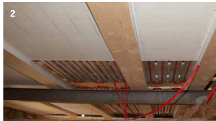
Klimatop-Profile zwischen den Balken verlegt und beplankt
